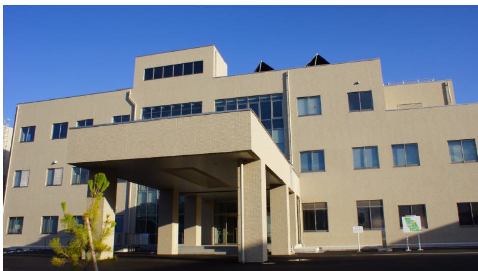
男川浄水場・管理棟
