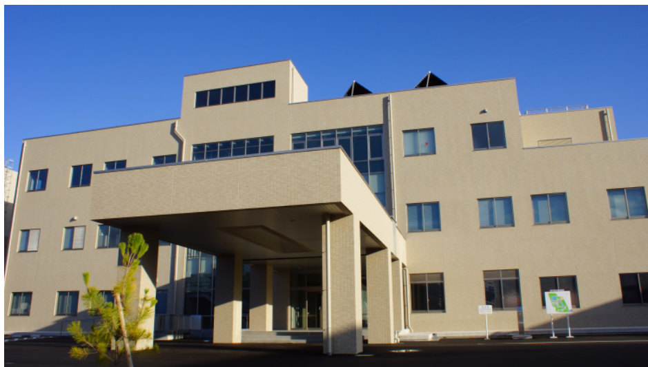
男川浄水場・管理棟
