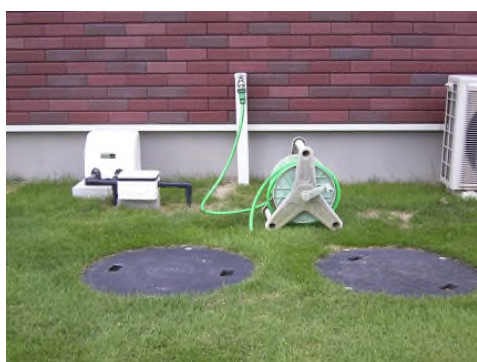
既存浄化槽転用雨水貯留槽設置例
