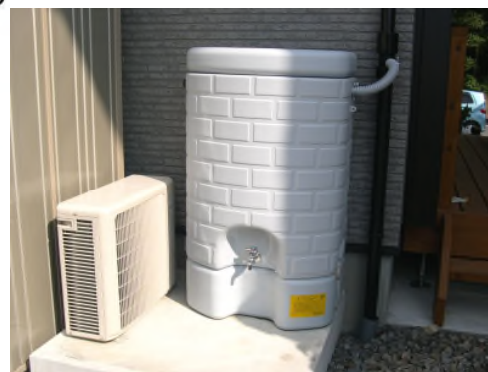
雨水貯留タンク設置例
