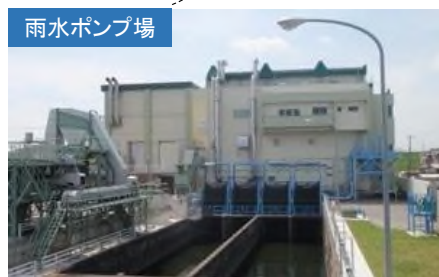
大門雨水ポンプ場(S56年) 市内最大の排水能力（43.3m 3 /s）を有した雨水ポンプ場です
