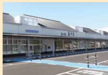
道の駅藤川宿 （藤川町）
