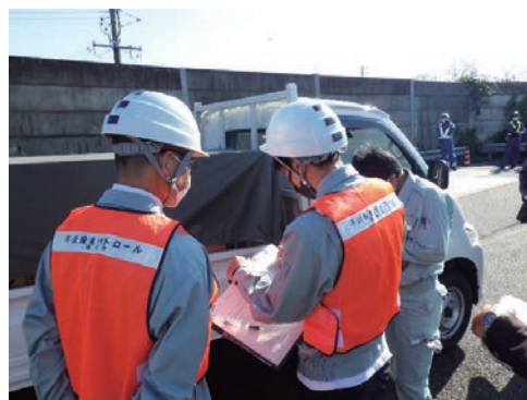
▲ 廃棄物を運搬する車両を路上で検査します。
