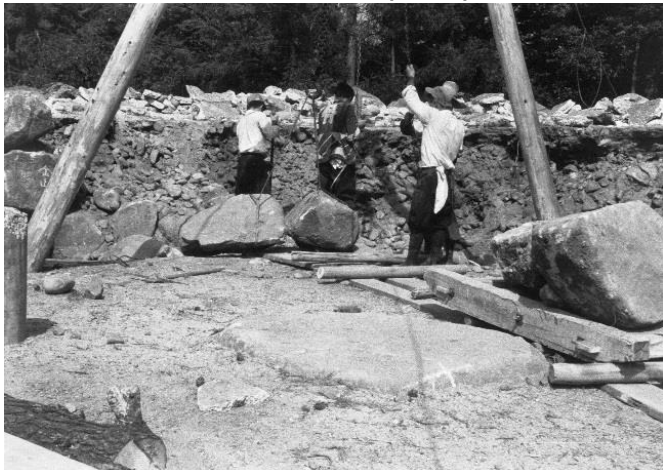
④天守復興工事 昭和 33 年(1958) 穴蔵（地階）石垣の解体。中手前に心礎が据わる。
