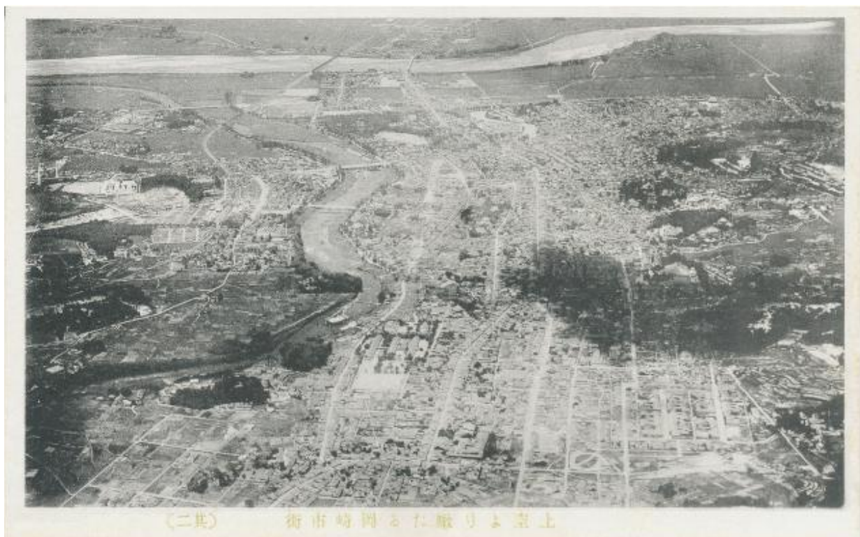
⑤総構えの俯瞰 大正末～昭和初期 （東から）
