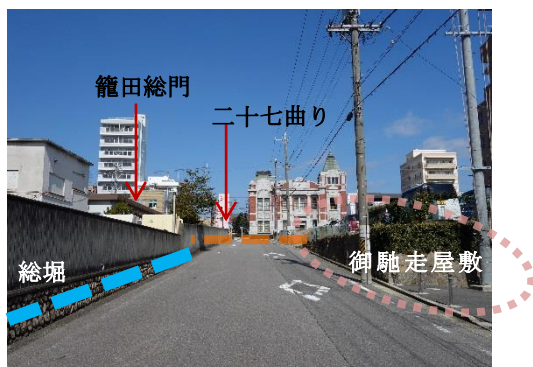
13 総堀と御馳走屋敷(南から)
