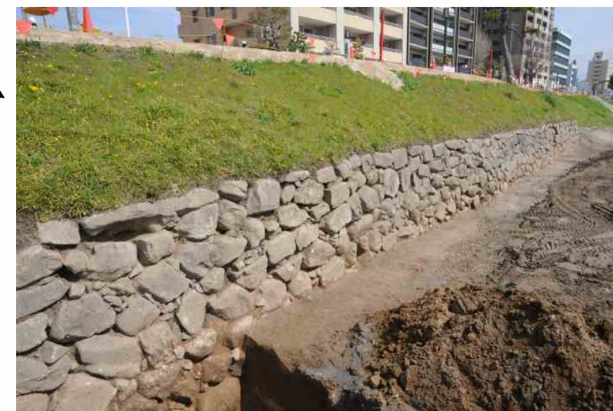
写真 1 地点⑥石垣検出状況 (調査後)
