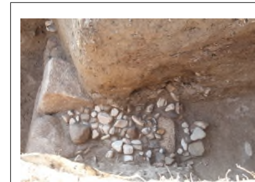
写真 2 石垣背後裏込め石
