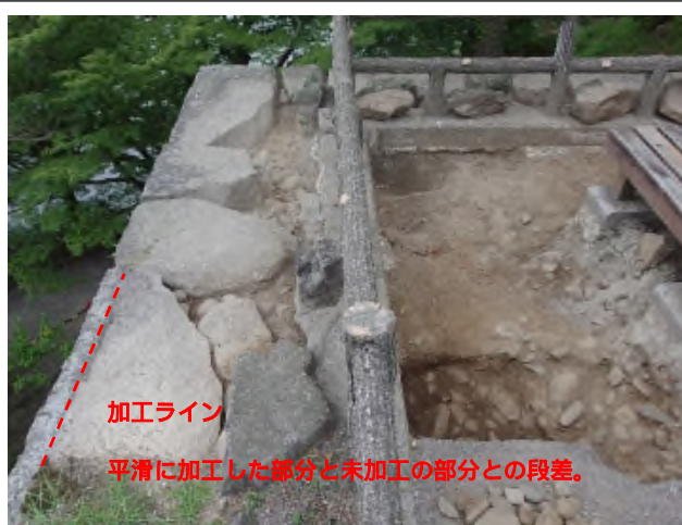
写真3 櫓台石垣の加工痕跡（東から） 土台木を載せるために石垣を平滑に加工している
