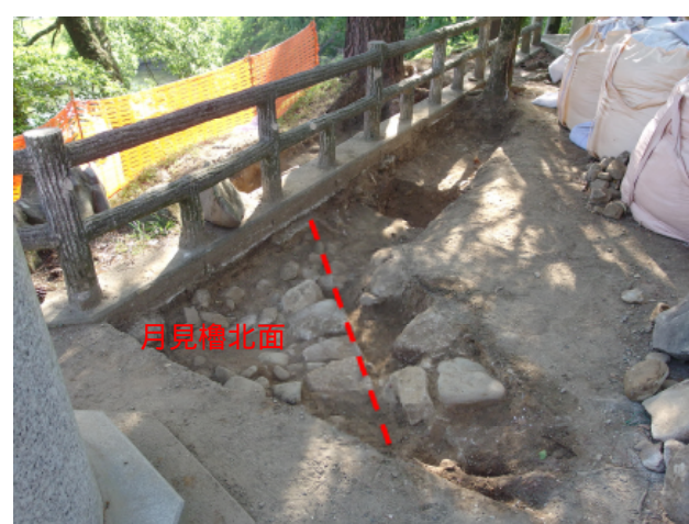
写真2 トレンチ 全景（東から）
