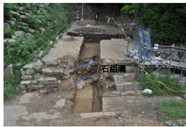
写真2 H26年度調査 枡形・切通し（南から）
