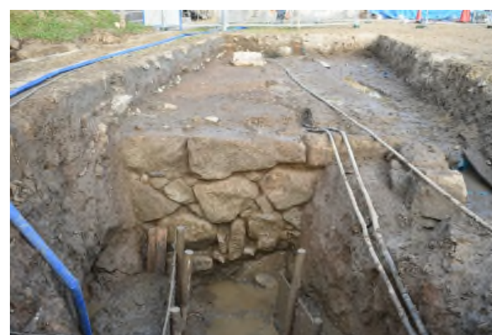
写真4 調査区2 菅生曲輪北側堀石垣（西から）
