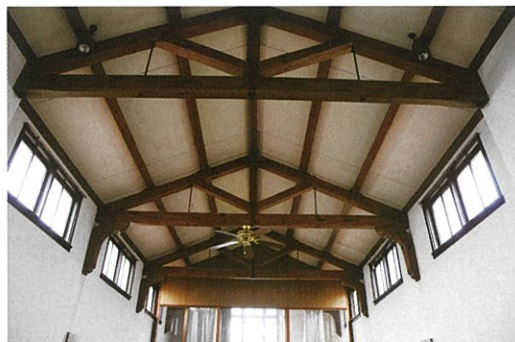
キングポストトラスの天井
