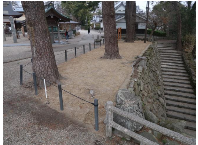
写真 11 石垣保存修理工事(完成後)
