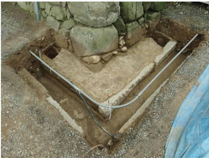
写真4 天守台石垣北西隅角部
