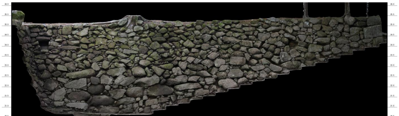
図 4 石垣測量図(風呂谷門西袖石垣)
