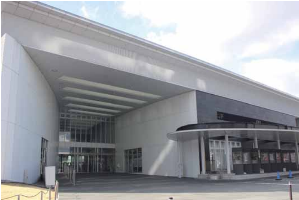
図書館交流プラザ・りぶら
