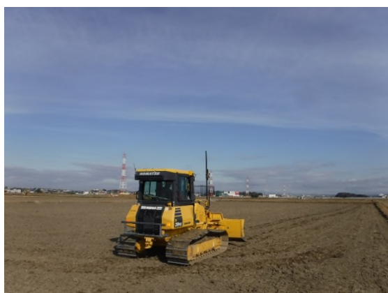
【ほ場整備工事】
