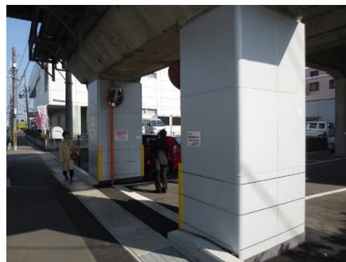
【橋脚の耐震補強】
