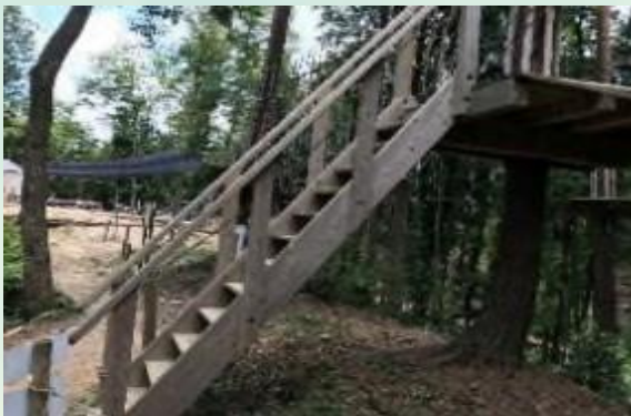
木製階段(ステア)
