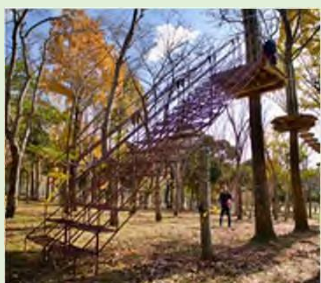
鉄製階段(ステア)
