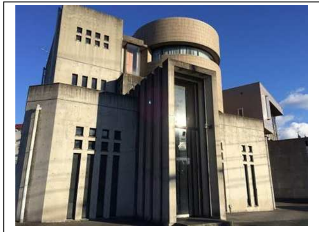
【S-tep ステラ 外観】
