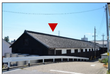
図2-5-18 ②新甲子蔵 (昭和14年(1939)建築)
