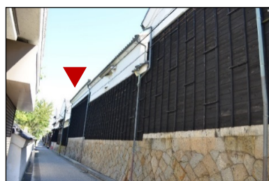
図2-5-22 ⑦乾蔵 (明治7年(1874)建築)
