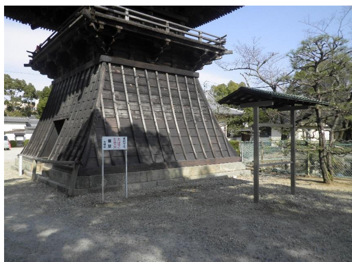
修理後(大樹寺鐘楼の袴板補修等)
