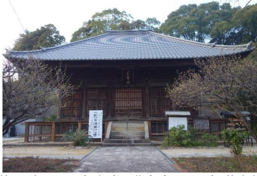
修理後(甲山寺本堂(護摩堂)の屋根葺き替え等)
