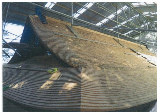
修理後(六所神社社殿(神供所)の屋根葺き替え等)
