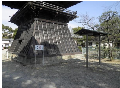
修理後(大樹寺鐘楼の袴板補修等)
