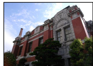
第10号 岡崎信用金庫資料館 (旧岡崎銀行本店) (指定日:平成29年10月31日)
