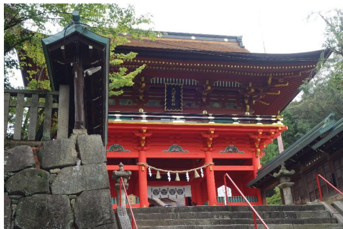
修理後(六所神社社殿(楼門)の塗替補修等)
