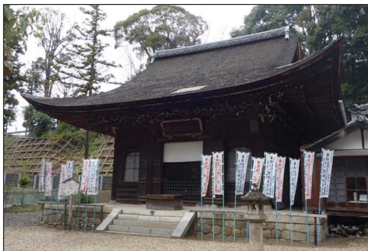
信光明寺観音堂(修理前)
