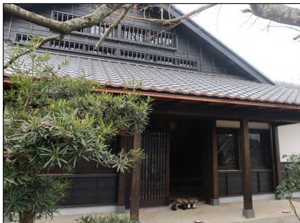
旧富田家住宅(主屋) (屋根・外壁の修理)
