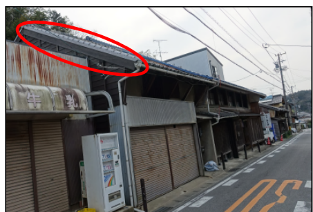
旧野村家住宅(米屋)(外観及び屋根修景)
