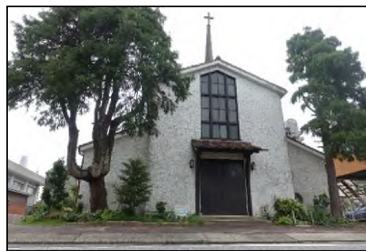
第11号 日本福音ルーテル岡崎教会 教会堂 (指定日:平成30年(2018)9月1日)
