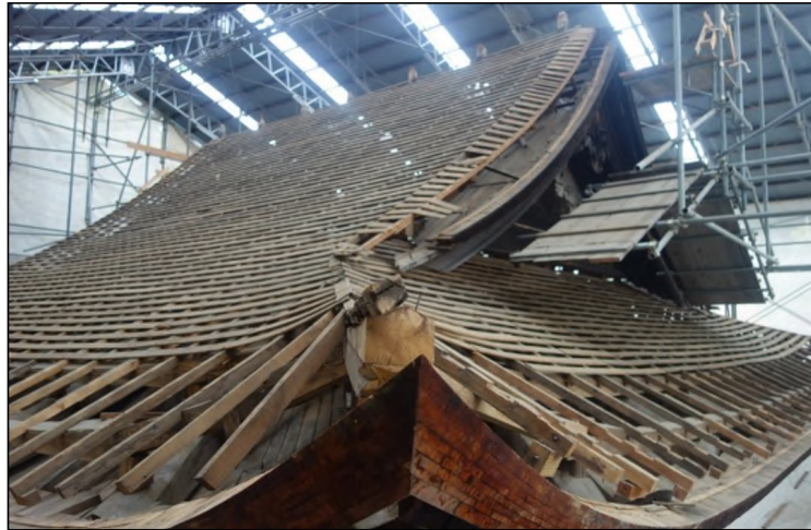
信光明寺観音堂こけら葺屋根葺替風景
