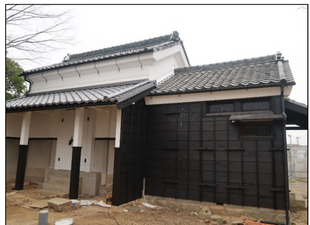
旧富田家住宅(土蔵) (屋根瓦・外壁の修理)
