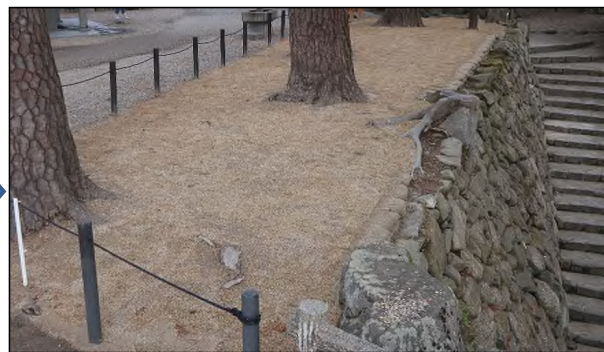
【施工後】土嚢で天端を固定し土盛りで勾配を付け、天端石の土砂の流出を防ぐ
