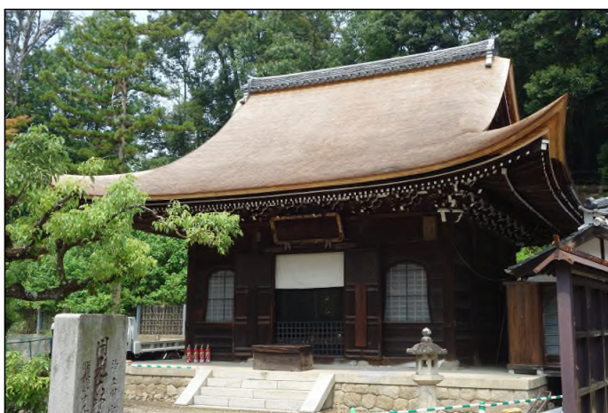
信光明寺観音堂(修理後)
