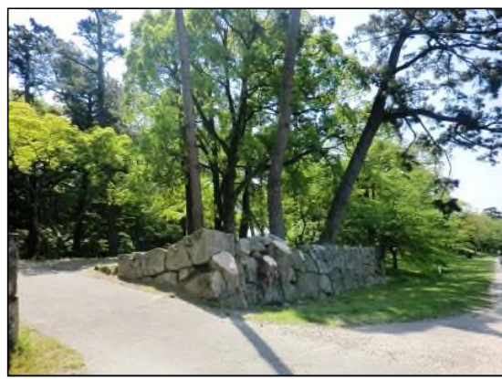
坂谷門石垣樹木伐採後(令和2年3月撮影)
