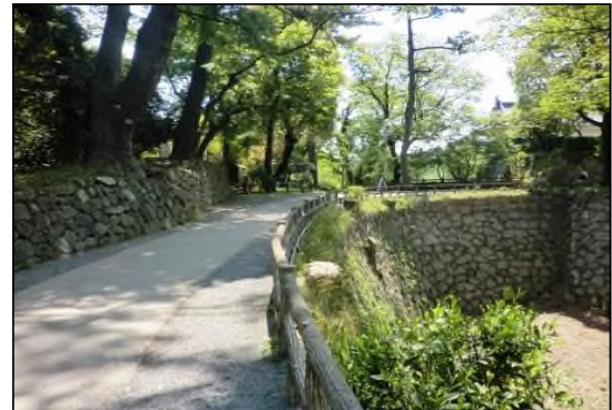
清海堀石垣樹木伐採後(令和元年8月撮影)
