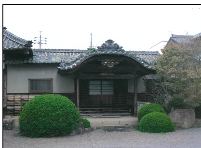
善立寺 玄関 修理前
