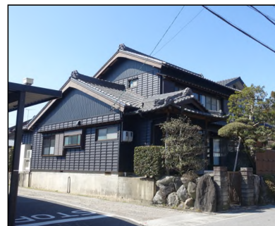
江坂邸(外壁修理)
