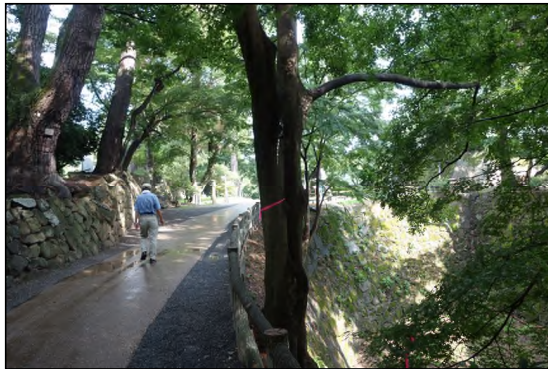
清海堀石垣樹木伐採前(令和元年5月撮影)
