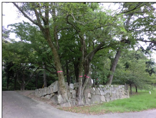
坂谷門石垣樹木伐採前(令和元年11月撮影)
