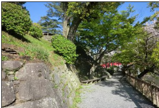
月見櫓台石垣樹木伐採前(令和2年4月)
