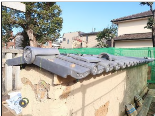
土塀瓦の葺替
