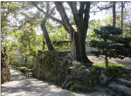
本丸埋門石垣樹木伐採前(令和2年4月)
