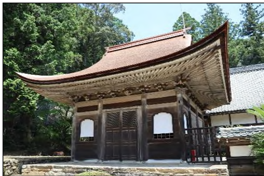
保存修理後:屋根葺替及び部分修理
