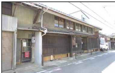
旧野村家住宅(米屋) 耐震補強工事
