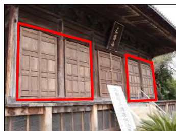
甲山寺(本堂)扉修繕工事
