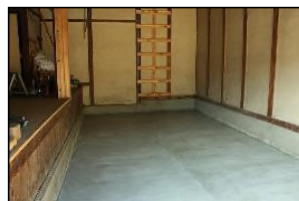
山車小屋土間の修繕
