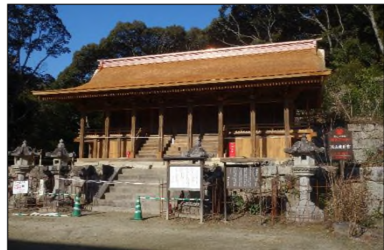
保存修理後:全解体修理
