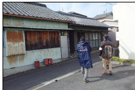
歴史的建造物悉皆調査
