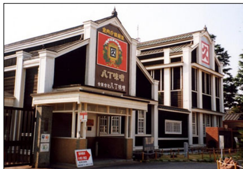
図4-17 カクキュー本社事務所
