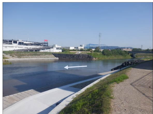
整備状況 (御用橋下流)
