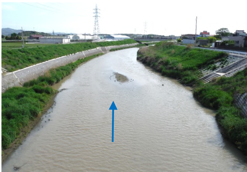
岩根上橋から下流を望む（安城市小川町地内）
