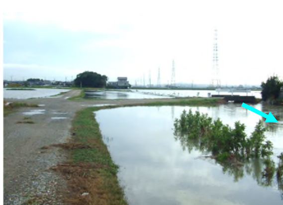
西鹿乗川（安城市安城町、上条町地内）
