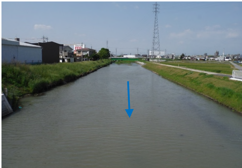
下川田橋から上流を望む（岡崎市大和町地内）
