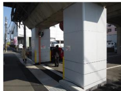
【橋脚の耐震補強】
