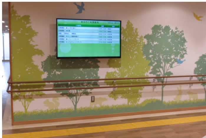
▲ 手すりの設置状況
