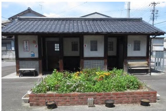
▲公衆便所（全景）
