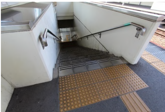
▲3階ホームから2階改札口への階段
