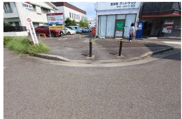
▲交差点部で急こう配の箇所
