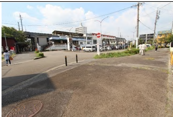
▲横断歩道がない箇所
