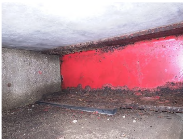
写真 1 主桁の腐食(Ⅲ判定)
