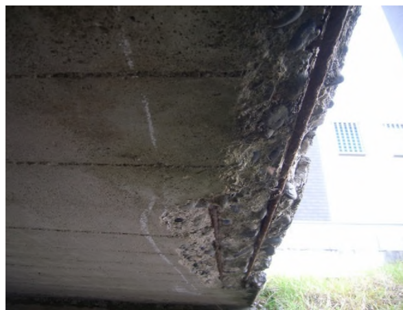
写真 2 主桁の剥離・鉄筋露出(Ⅲ判定)
