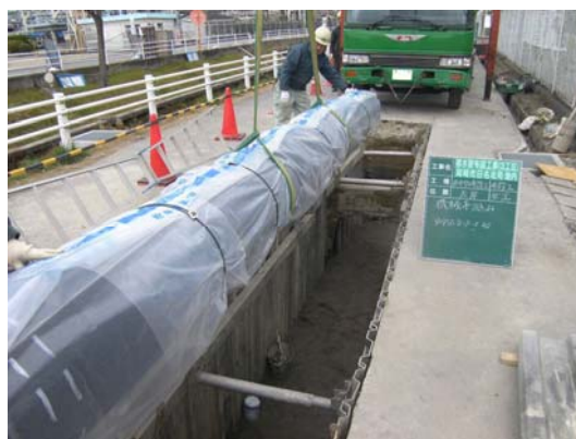
【水道管の布設替状況】
