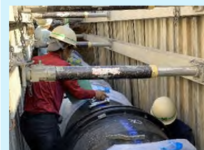
基幹管路布設工事
