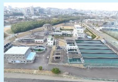
旧男川浄水場
