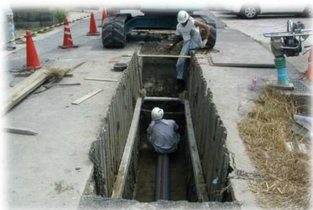
(下水道管工事の様子)
