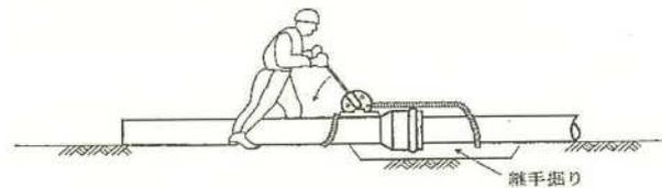
図 3-24 挿入機による差し込み
