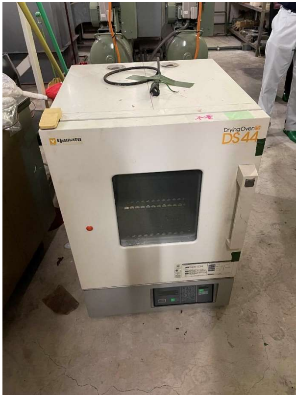
【図表 4－22－3】換気機械室で保管されていた不要機器
