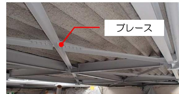
天井へのブレース（筋交い）設置状況
