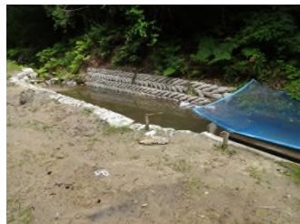
小川を堰き止め、取水
