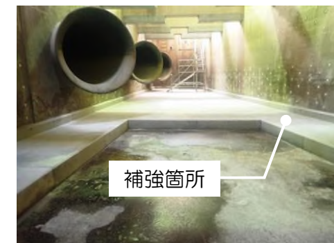
コンクリート増打による耐震補強
