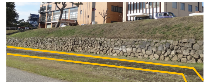
菅生川端石垣整備工事（樹木の伐採、擬石積み及び階段の撤去・埋没石垣の列表示・園路整備）
