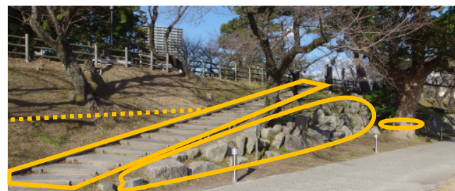
菅生川端石垣整備工事（樹木の伐採、擬石積み及び階段の撤去・埋没石垣の列表示・園路整備）
