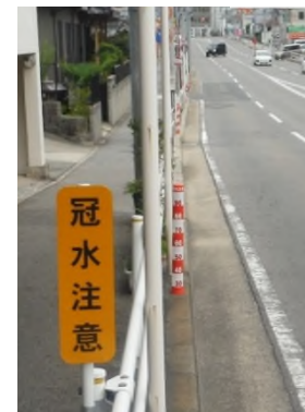
浸水深表示施設(設置例)
