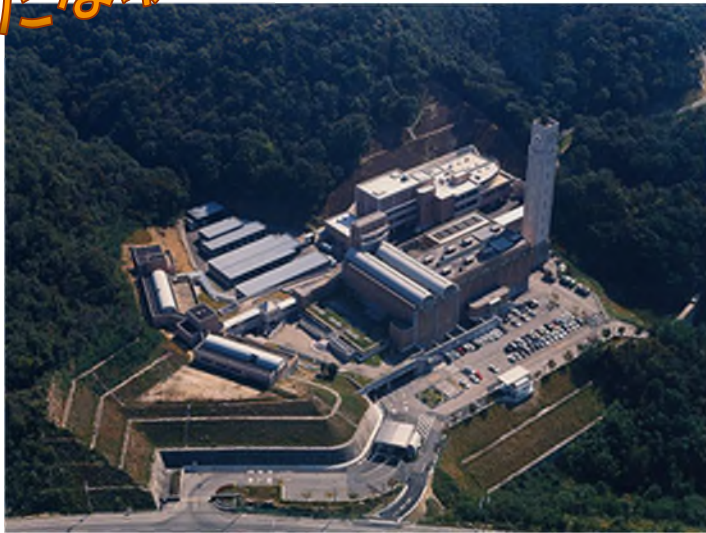
リサイクルプラザ (旧中央クリーンセンター)
