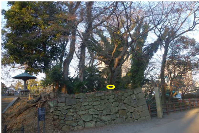
石垣を毀損する樹木の伐採
