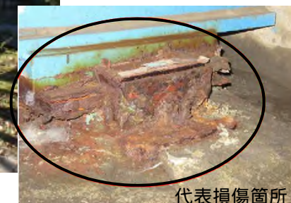
令和4年度修繕予定 長沢連橋 (中金町)
