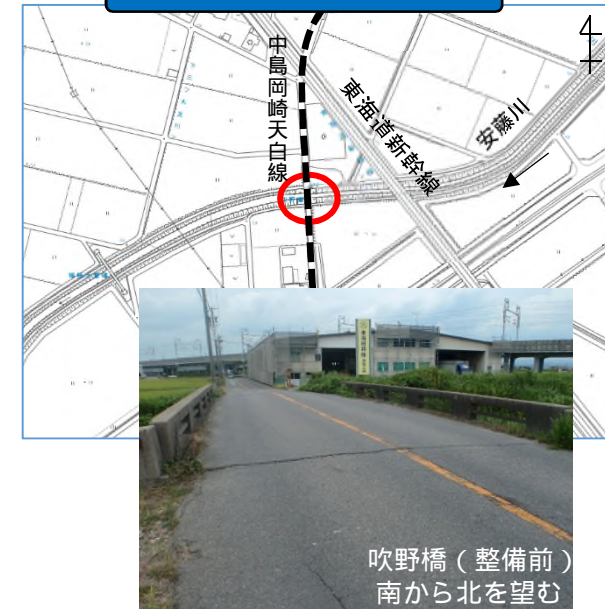
吹野橋(安藤川)
