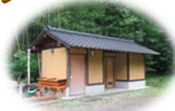
施設唯一の便所(循環式)
