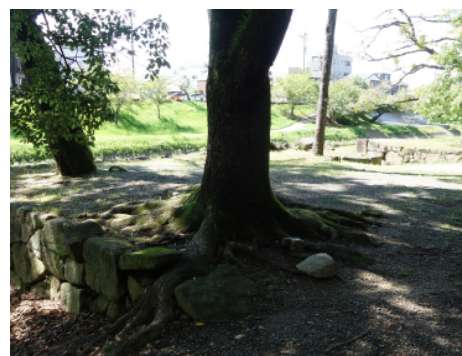
石垣を毀損する樹木の伐採
