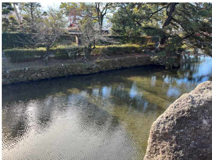
石垣測量箇所（龍城堀石垣）
