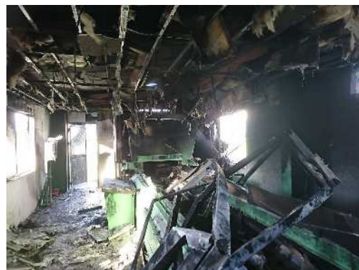
バッテリーが原因で火災にあったリサイクル工場 出典：(公財)日本容器包装リサイクル協会
