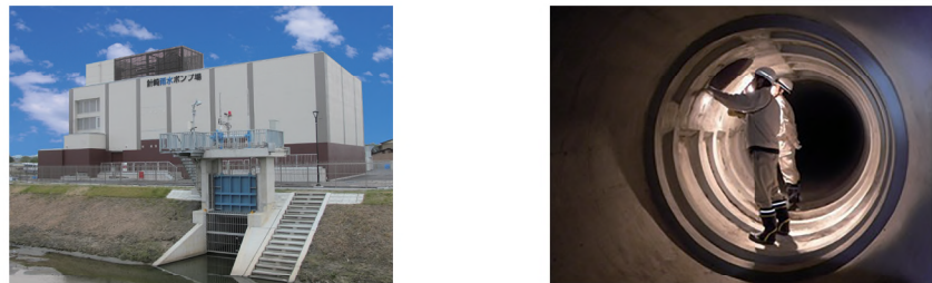
<雨水ポンプ場(針崎町)>
