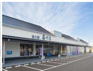
道の駅藤川宿 (藤川町)
